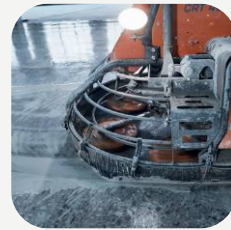
PULIDO DE HORMIGÓN
